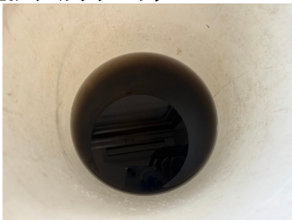
16.エアコンクリーニング
