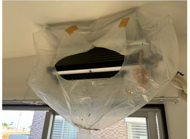
16.エアコンクリーニング
