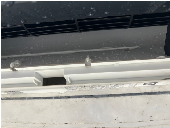
16.エアコンクリーニング
