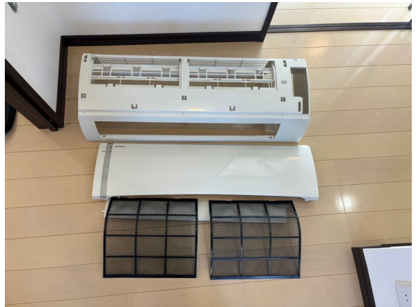
16.エアコンクリーニング
